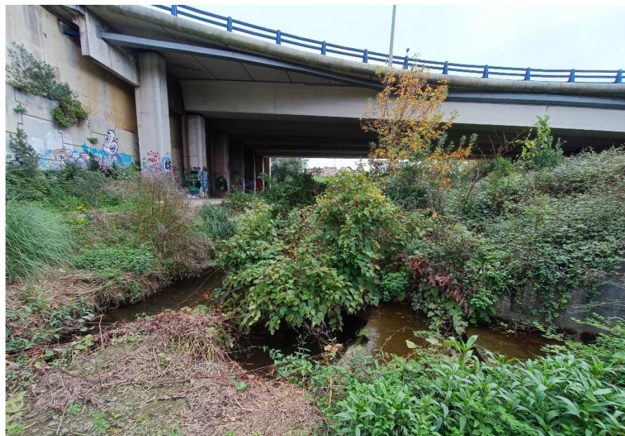
Figura 33: Paso elevado sobre el río Ballonti. Fuente: elaboración propia a partir de la visita de campo de octubre de 2022.
