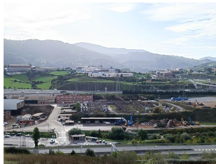
Figura 25: Infraestructuras eléctricas ubicadas próximas al trazado planteado. Fuente: elaboración propia a partir de la visita de campo realizada en octubre de 2022.
