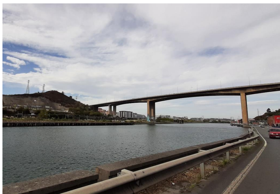
Figura 38: Puente de Rontegi desde la Margen Derecha. Fuente: elaboración propia a partir de la visita de campo de octubre de 2022.
