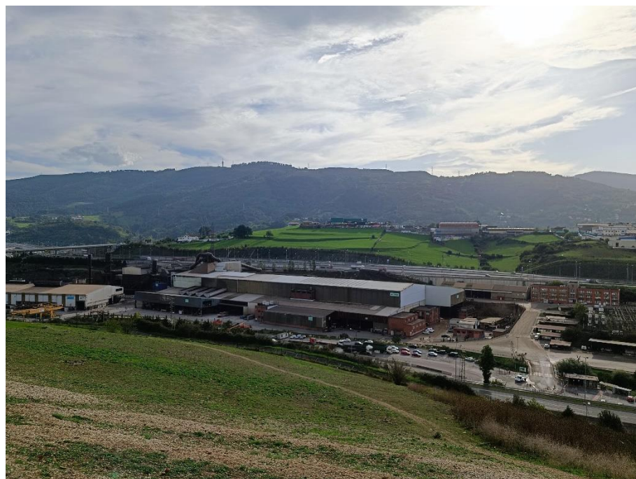
Figura 34: Acería anexa a las actuaciones proyectadas en la Margen Izquierda. Fuente: elaboración propia a partir de la visita de campo de octubre de 2022.
