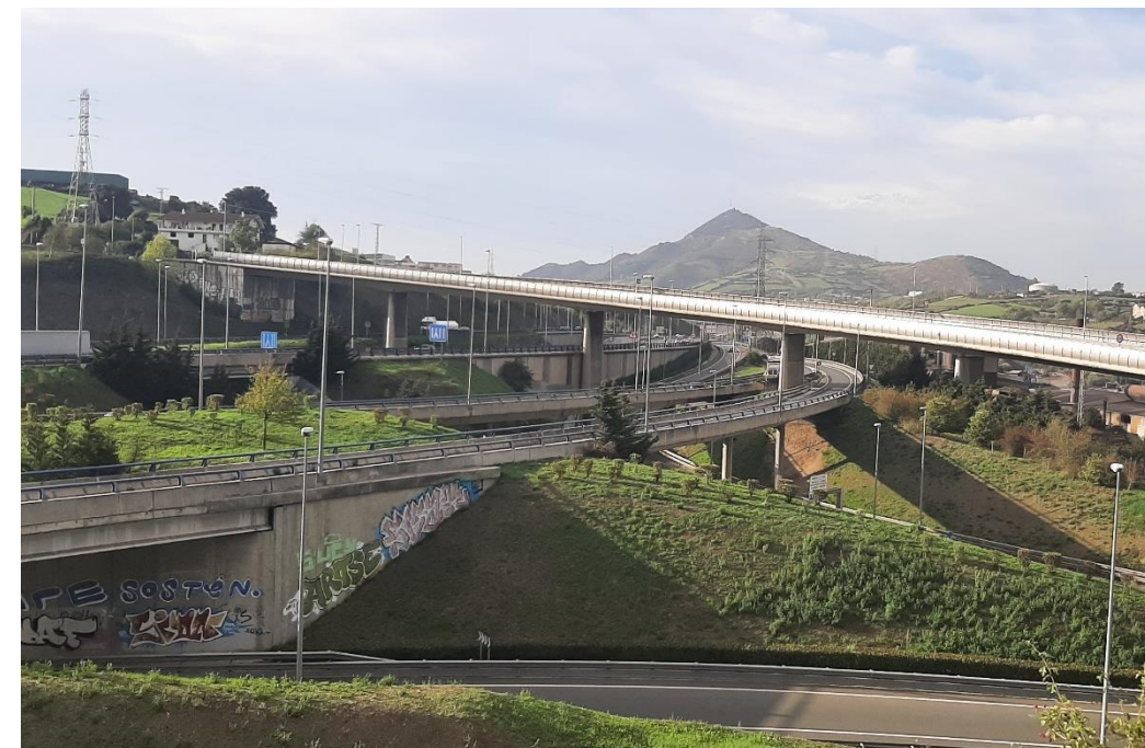
Figura 35: Nudo vial sobre la A-8 en el entorno de la Margen Izquierda. Fuente: elaboración propia a partir de la visita de campo de octubre de 2022.
