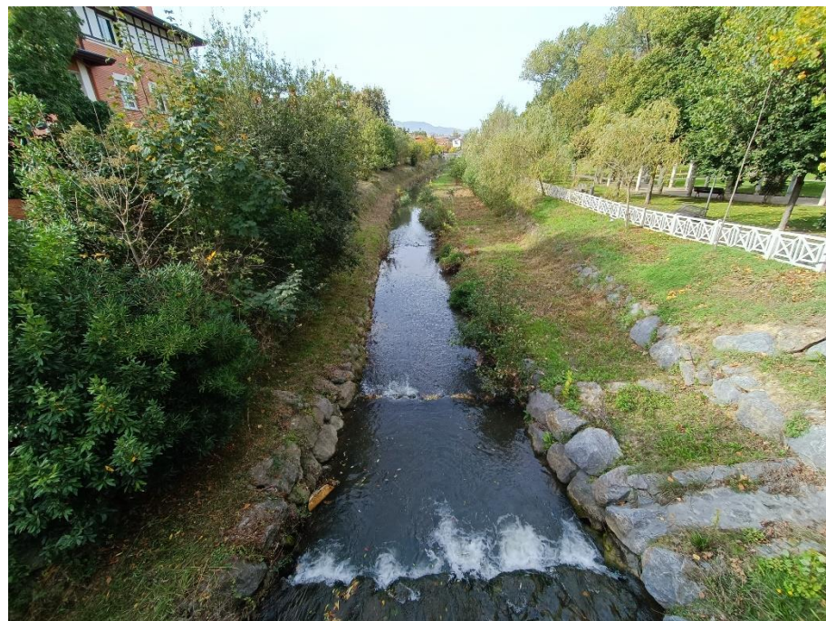
Figura 40: Canalización del río Gobela en el entorno de la Margen Derecha. Fuente: elaboración propia a partir de la visita de campo de octubre de 2022.
