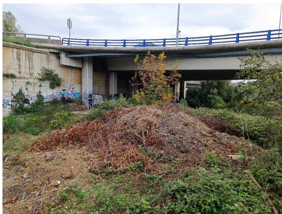
Figura 26: Paso elevado sobre el río Ballonti. Fuente: elaboración propia a partir de la visita de campo realizada en octubre de 2022.
