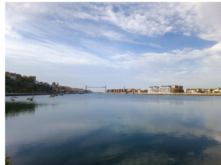
Figura 11: Paisaje de la ría de Bilbao con la presencia del puente colgante. Fuente: elaboración propia a partir de la visita de campo realizada en octubre de 2022.
